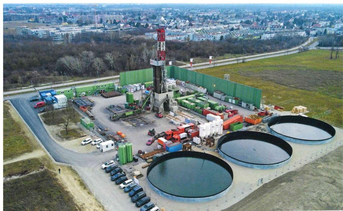
OMV und Wien Energie bohren im Joint Venture „deelep“ rund 3.000 m in die Tiefe, um das natürliche Heißwasservorkommen im „Aderklaaer Konglomerat“ zu nutzen. Durchgeführt wird die Bohrung durch die RED Drilling & Services GmbH. Zum Einsatz kommt eine Bohranlage Bentec Euro RIG 250.
